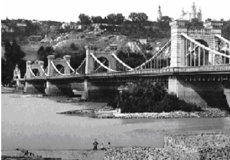
Рис. 2. Николаевский цепной мост (закладка 1848 – окончание строительства и освящение 1853; взорван в 1920)
